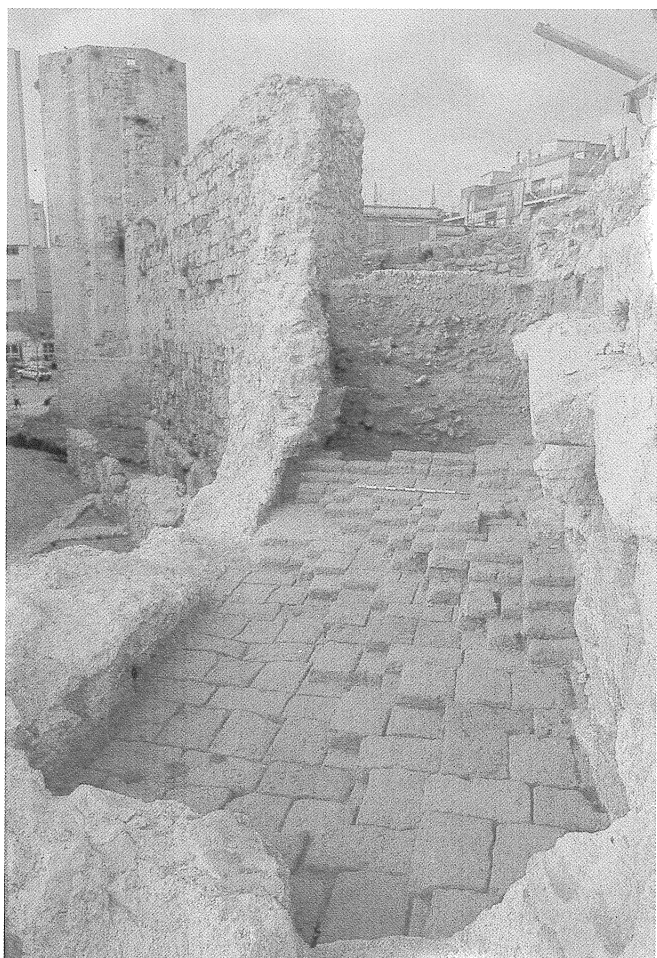
Fig. 11. - Vista del sector 1200, una vegada delimitats els tovots conservats a l'interior de la muralla.
