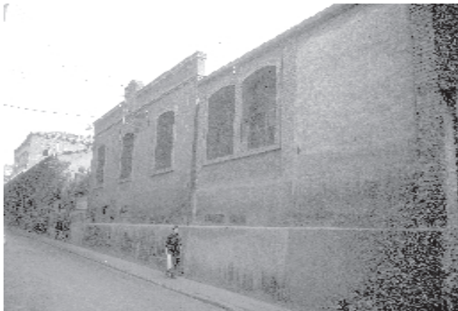
Fig. 1. Vista exterior de la Escuela Pericial de Comercio situada al carrer Governador Montcada. Les dues primeres finestres de la dreta corresponen a l'habitació on hi havia el material de Gebut l'any 1980 (fot. Joan-Ramon González).
