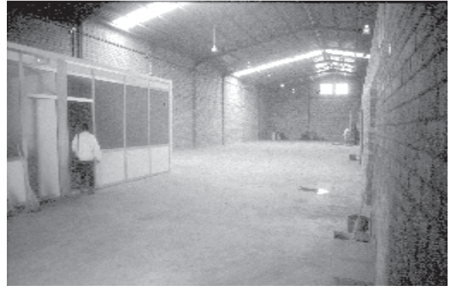
Fig. 11. Vista del magatzem abans de portar-hi el material (fot. Josep Ignasi Rodríguez. Servei d'Audiovisuals de l'IEI).
