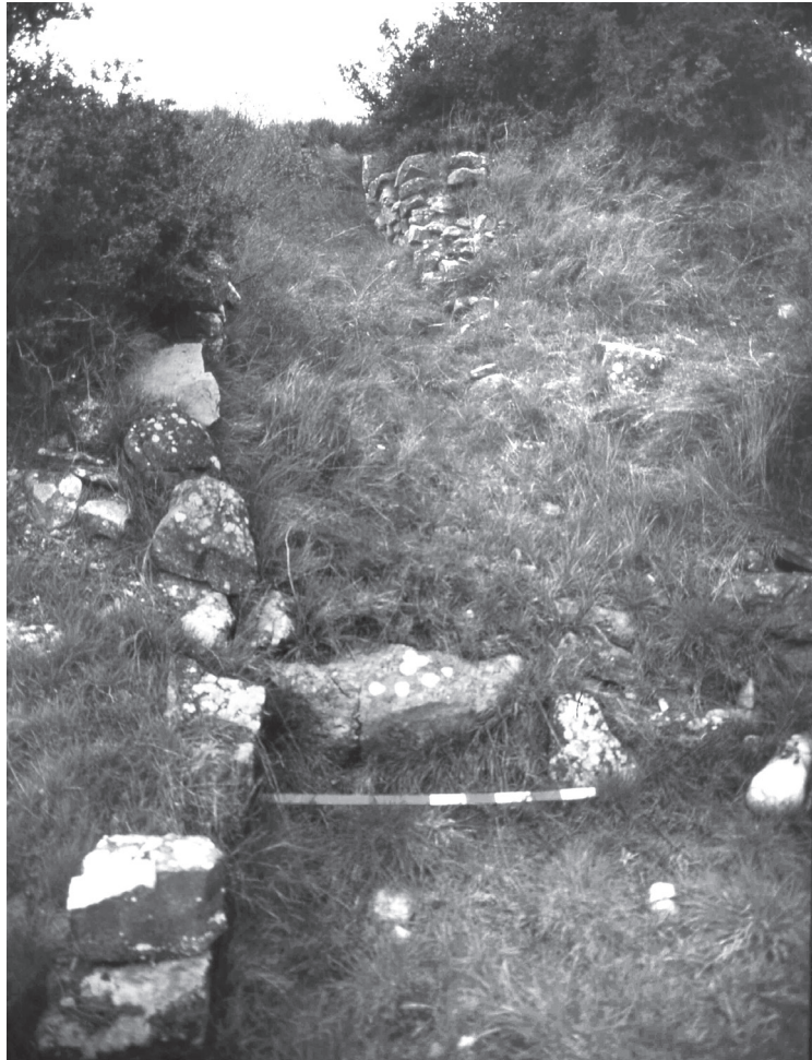
Fig. 21. Vue depuis l'est de la probable poterne située au départ du couloir d'accès à la porte orientale du Cayla de Mailhac (© E. Gailledrat).
