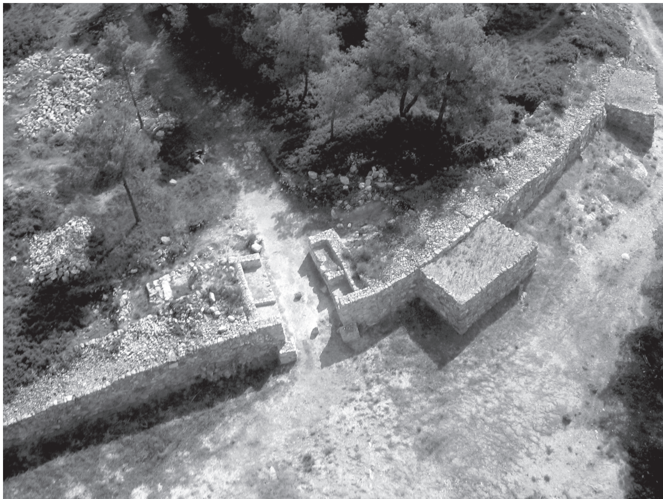
Fig. 15. Vista aérea de la Puerta Oeste y la muralla con las dos torres (Archivo SIP).
