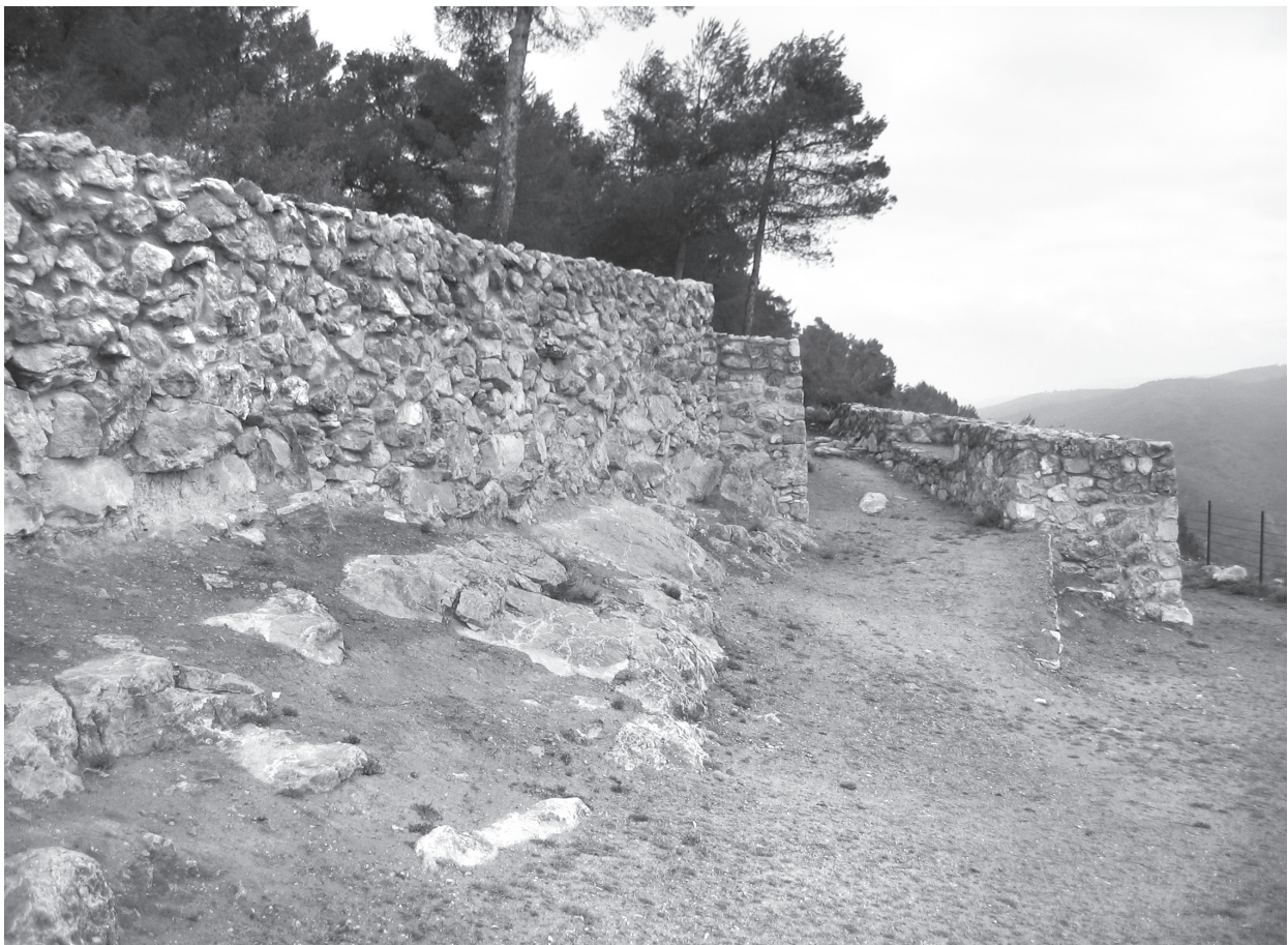
Fig. 11. Vista exterior del estado actual de la Puerta Sur, ya consolidada (Archivo SIP).
