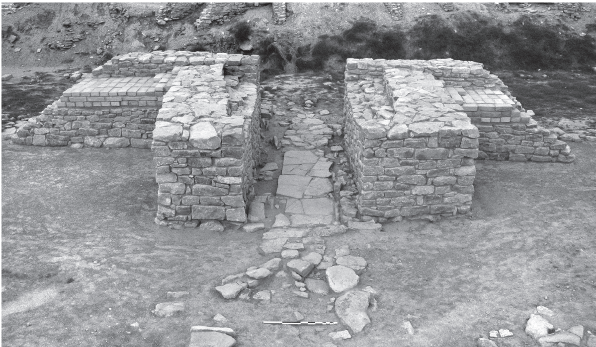
Figura 13. Vista de la torre-porta T-319 restaurada.
