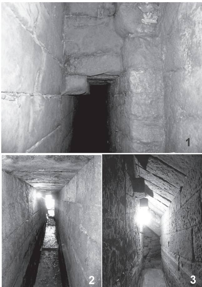
Fig. 13. Vistes del segon tram de la mina.
