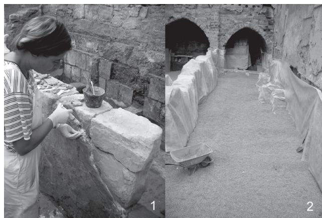
Fig. 3. Treballs de consolidació i protecció de les adoberies.
