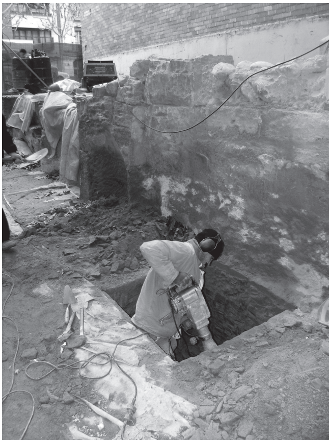
Fig. 4. Detall dels treballs d'excavació dels pous de fonamentació del nou edifici.
