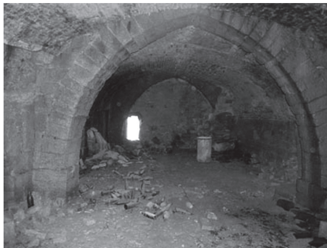
Fig. 11. Vista general del celler des de ponent. Al fons, l'obertura realitzada en el tapiat durant els treballs d'excavació.
