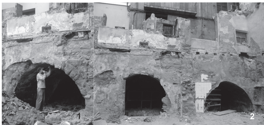
Figura 87. 1. Vista dels treballs de repicat dels arrebossats de ciment que cobrien l'intradós de les voltes, duts a terme a peu pla a causa del considerable augment del nivell ocorregut al llarg de les fases X i XI; 2. Estat del pati després d'enderrocar la casa de la rambla Ferran número 7.
