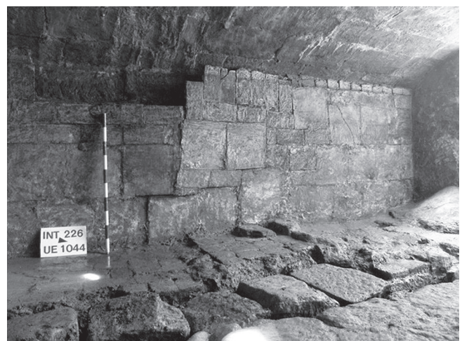
Figura 81. Vista del revestiment i cambra que tapa la paret/estrep de la volta original del celler.
