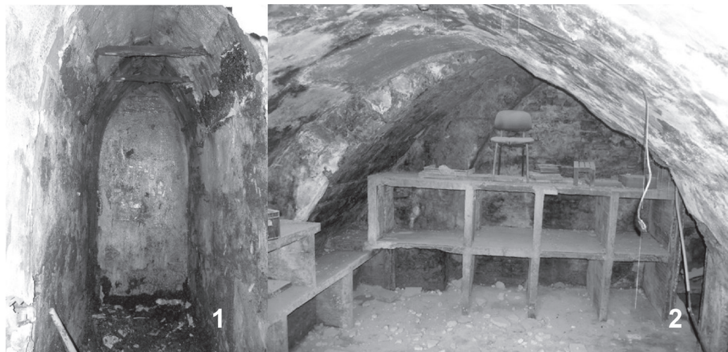
Fig. 88. 1. L'entrada a la mina tapiada després de retirar la cambra de revestiment; 2. Estat de l'interior de les voltes amb les prestatgeries de begudes utilitzades pel bar Las Vegas.
