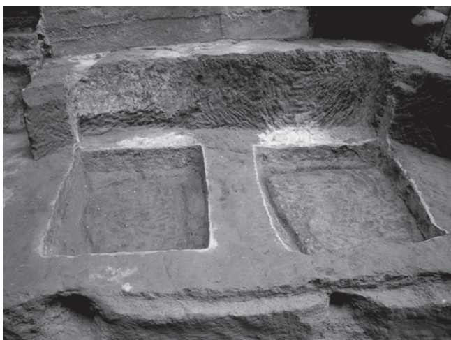
Fig. 38. Vista del fons del quart (u.e.: 1299) i cinquè (u.e.: 1297) clot/dipòsit de la bateria d'estructures adossades al tancament nord de l'adoberia núm. 6. S'aprecien els canals interiors i els forats de desguàs al canal central. S'observa també la banqueteta nord de treball reduïda per un repicat de la fase posterior que augmenta la superfície dels nous clots (vegeu fase III i IV).
