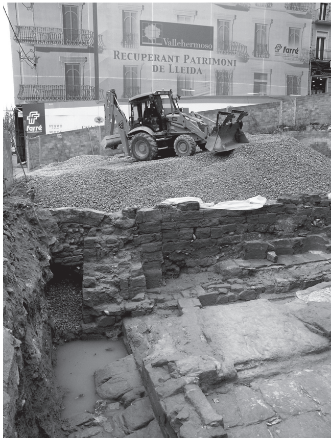
Fig. 2. Treballs previs a la construcció del nou edifici sobre les adoberies 1-4.
