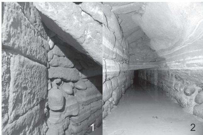
Fig. 15. Vistes del primer tram de la mina.
