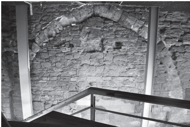
Fig. 10. Vista de l'arc de descàrrega de la paret de tancament nord de l'adoberia núm. 6 descobert durant els treballs de restauració de la sala.
