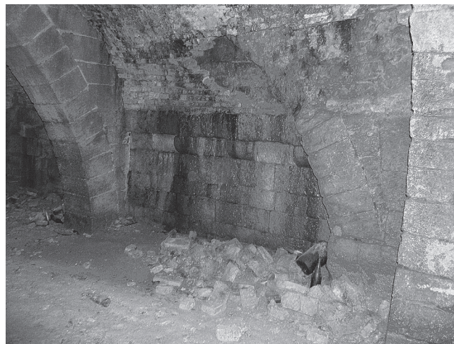
Fig. 14. El repicat de l'arc de descàrrega seguint la línia de lloses que a la banda oposada del mur són la coberta de la mina i les tres mènsules de recolzament. Un pla avançat en relació amb el mur de tapiat original entre els arcs de descàrrega de la paret nord, aprofitat d'imposta i estrep per a la nova volta de maons que actualment cobreix el celler.
