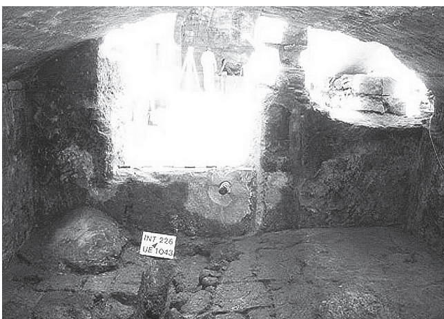
Fig. 80. Detall del tapiat de la porta d'accés al celler (u.e.: 1022) parcialment repicat. Observeu el forat de desguàs de les filtracions i el tap de fusta.
