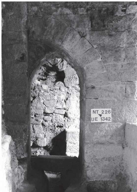
Fig. 24. Detall de la porta de comunicació entre les adoberies localitzada davall de les voltes de suport del carrer Blanquers. Al fons el tapiat de la porta de comunicació amb la suposada adoberia núm. 7.
