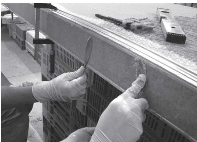
Figura 18. Procés d'aplicació de la capa de protecció i anivellament de tot el perímetre de les planxes amb resina epoxi.
