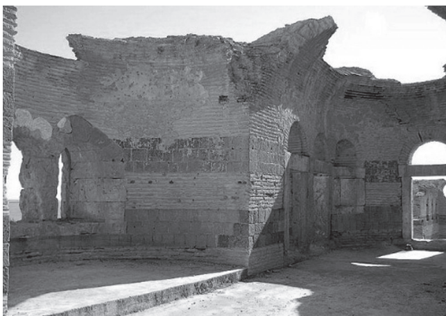
Figura 13. Imagen actual del aula de representación en el primer piso del ala sur después de las restauraciones. Todavía se pueden apreciar los restos del enyesado para la decoración pictórica (A. Perich).
