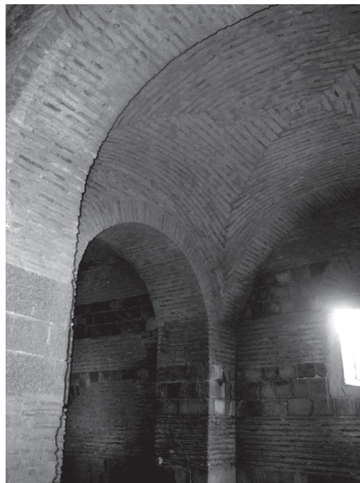
Figura 18. Imagen de la restauración de las bóvedas tabicadas (construidas enteramente en ladrillo) que cubrían los distintos ambientes del ala oeste del palacio de Qasr ibn Wardan (A. Perich).
