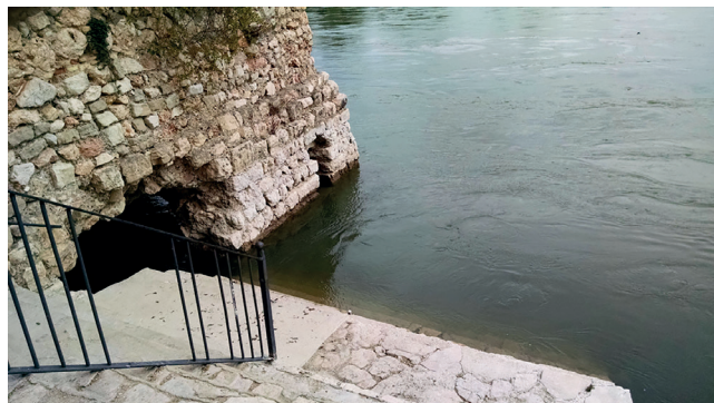
Figura 14. El riu Ebre al seu pas per Miravet. Estructura graonada semblant a la documentada al soterrani de la Paeria. Foto: Marta Morán (2016).
