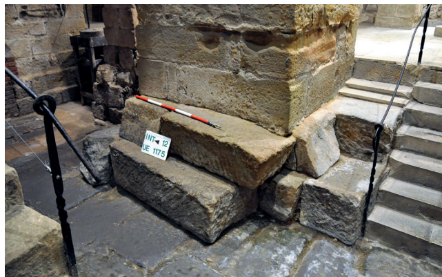
Figura 7. Assentament del pilar a sobre de la plataforma.
