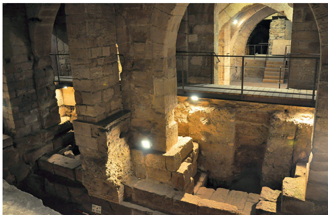
Figura 1. Vista del soterrani del palau dels Sanaüja-la Paeria.
