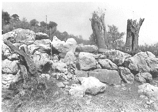
Fotografía 2. - Corredor de acceso destruido (a la derecha del jalón) del T4 desde el sur.
