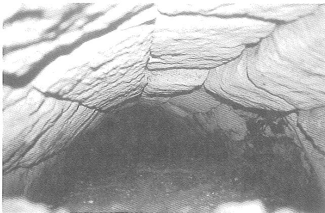
Fig. 21. Detalle de la cubierta del colector en el nuevo tramo recientemente descubierto bajo la c. Apodaca.
