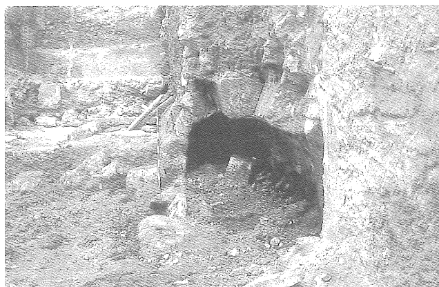
Fig. 3. Detalle de la cubierta y el lateral del gran colector, realizado en opus quadratum (Archivo CODEX).
