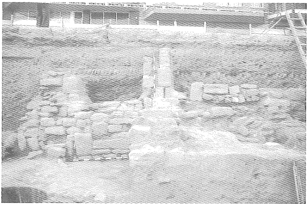
7.2.- Escalles i pilars amb l'arrencament de les voltes de sosteniment de la segona planta a l'antic Cinema Catalunya.
