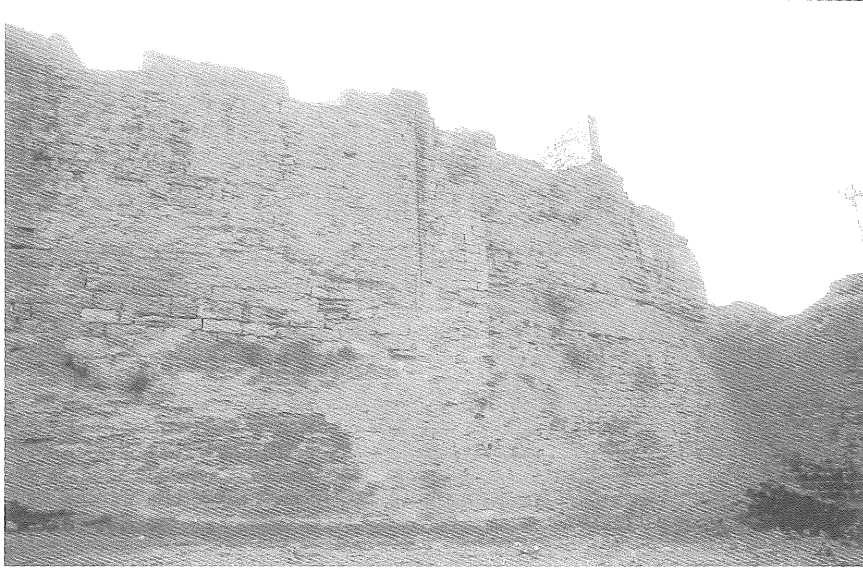
▲ 3.1.-Tancament nord-oriental del palau del Rei sobre l'antic tancament andalusí.
