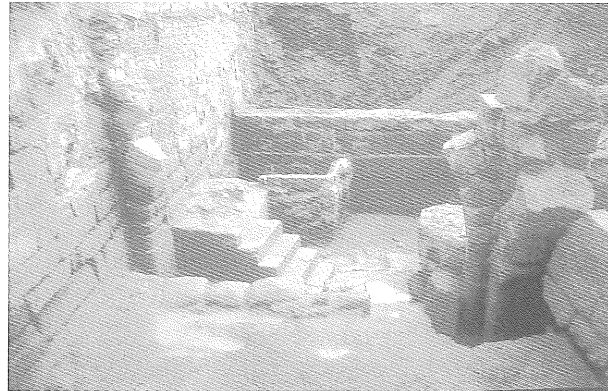
7.2.- Escalles i pilars amb l'arrencament de les voltes de sosteniment de la segona planta a l'antic Cinema Catalunya.
