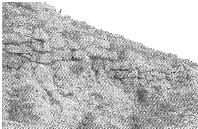
Foto 4. Tramo norte de la muralla de Cerro Cepero, la antigua Basti (Baza).
