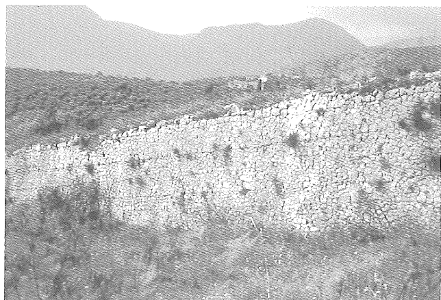
Fig. 19. Muralla de l'acròpolis de Tarracina . Detall de la seva cara interna d' opus incertum .
