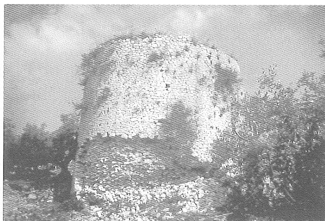
Fig. 20. Torre circular d' opus incertum de l'acròpolis de Tarracina .
