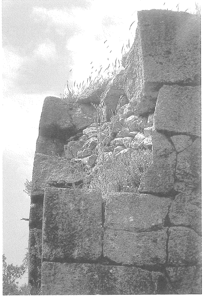
Fig. 10. Detall de la torre poligonal de Cosa . En l'angle derruït de la turris s'aprecia el farcit de pedruscall de la seva base massissa.
