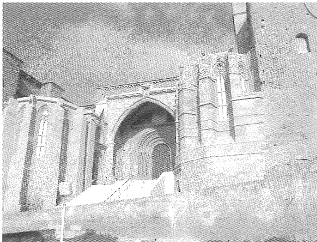
Fig. 19. Conjunt de l'entorn de Fillols ja restaurat, amb les noves escales i cobertes.
