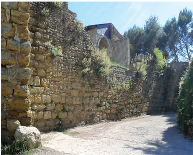
Figura 9. Sector 4 sencer. Llenç de muralla d'uns 20 m de llargada des de la torre rectangular fins a la primera torre semicircular, construïda al segle XIX.
