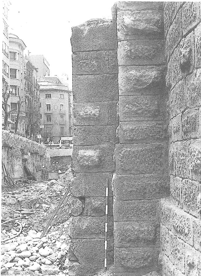
Figura 7. - Detalle del paramento almohadillado.
