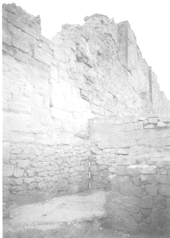
Foto 1. Vista exterior de la muralla nord de la Suda (Int-30).
