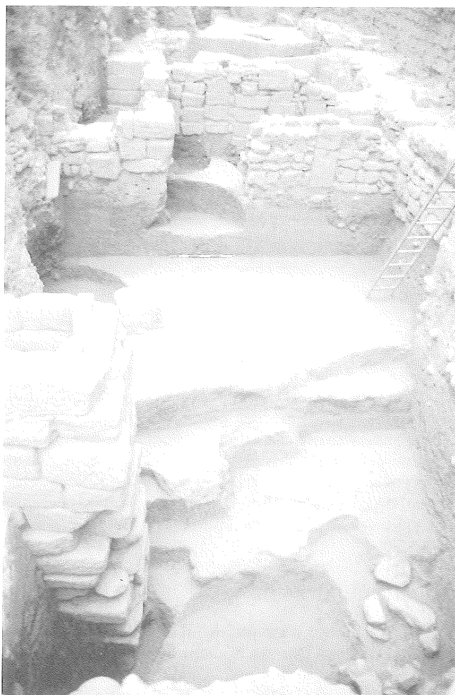
Foto 7. Tipus constructius emprats a les cases i als pous d'aigua. Intervenció del carrer Costa de Magdalena (Int-47).
