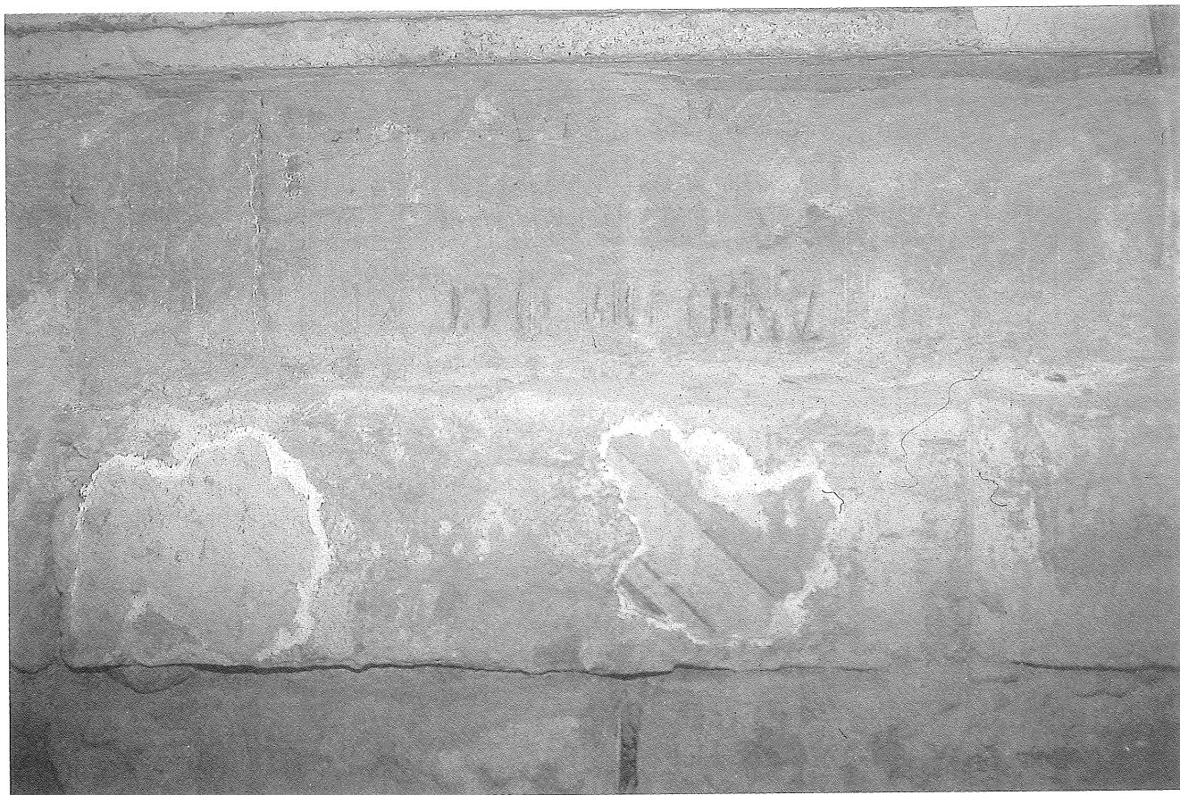
Fig. 9. Blocs de pedra reaprofitats en la construcció del mur que s'adossa per l'interior al mur de tancament sud de Santa Maria l'Antiga, que molt probablement provenguin de l'enderrocat mur de divisió entre les naus de Santa Maria i la Pia Almoïna. En la inscripció epigràfica es pot llegir la data de 1211.
