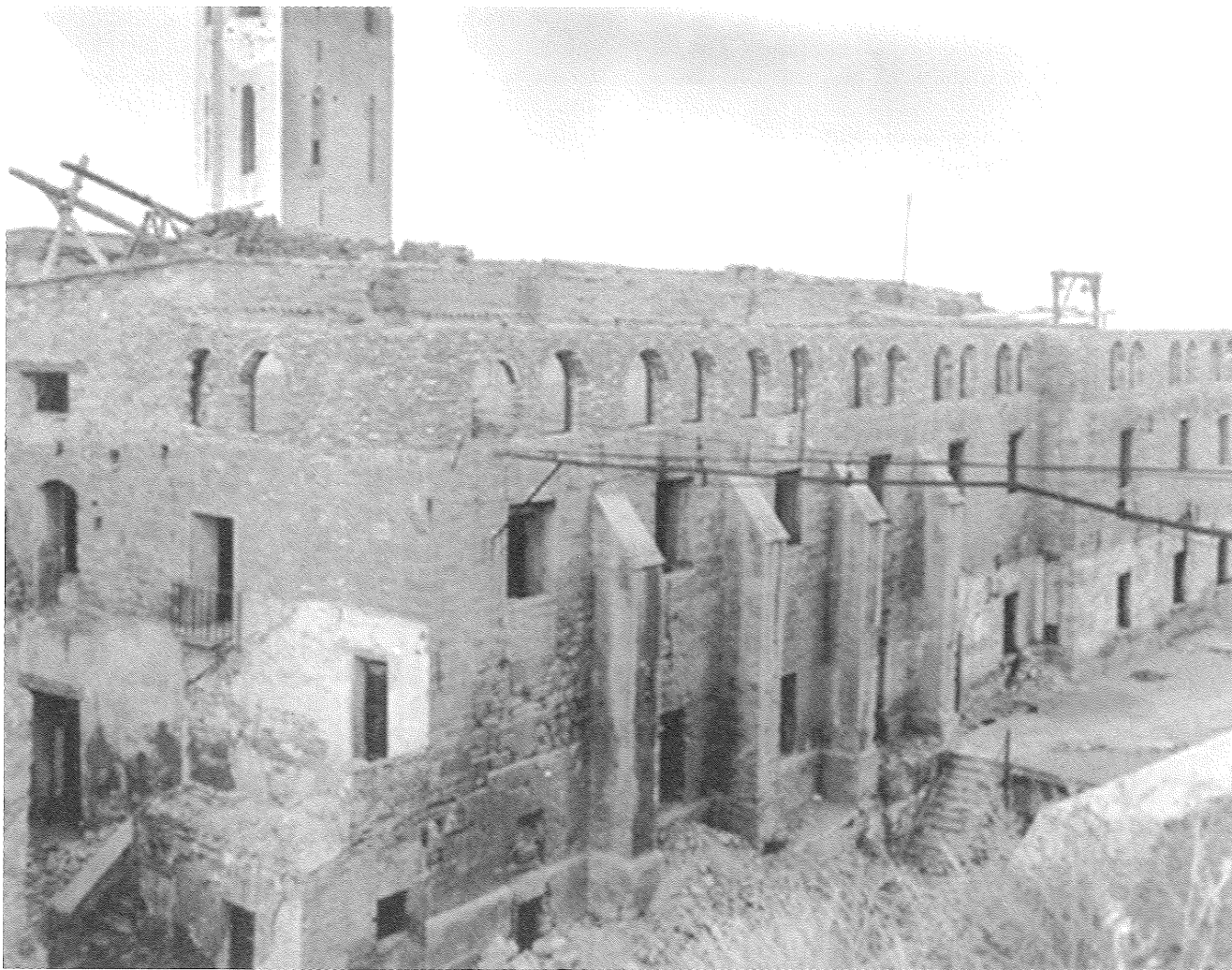
Fig. 27. Primers moments de les obres d'adequació de les construccions de la canonja com a casa d'exercicis. Vista de l'angle nord-est. Anys cinquanta (Arxiu Ferrant. Col·legi d'Arquitectes de Catalunya. Demarcació de Lleida).
