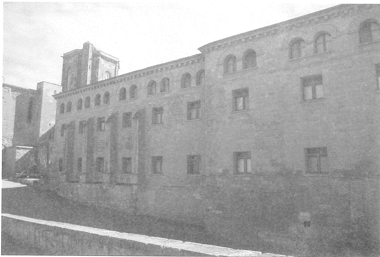
Fig. 17. Façana nord de la canonja: la construcció més al fons amb contraforts exteriors correspon molt probablement a l'antiga degania. Els contraforts es recolzen sobre les margues naturals, que foren folrades amb pedra al segle XVIII quan les obres de fortificació del turó suposaren la destrucció del carrer que passava paral·lel a aquesta façana.
