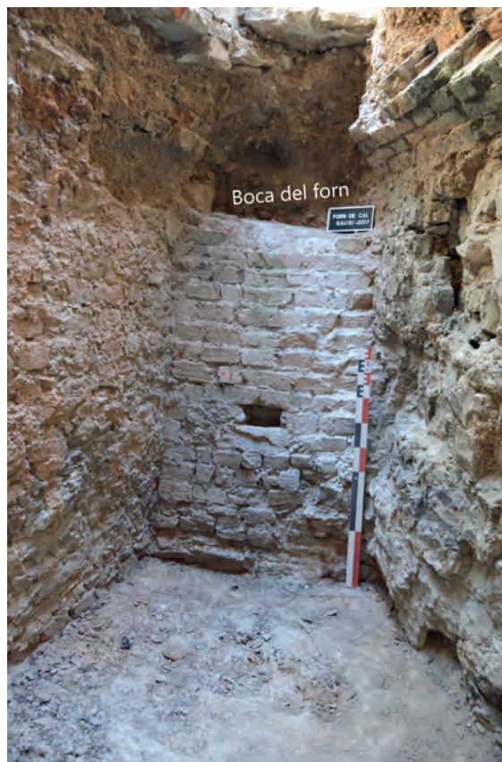
Figura 14. Zona de la boca del forn. El maó que falta a la paret de sota la boca serviria per baixar al forn de baix (Autoria: R. Cardona Colell).
